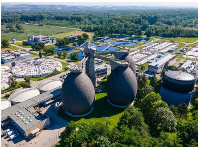
Die Leistungssteigerung in der Regionalkläranlage Linz-Asten sichert die Abwasserentsorgung heute und in Zukunft.
