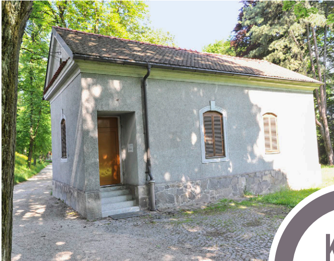
LINZ AG WASSER baut eine zusätzliche Druckerhöhungsanlage im Hochbehälter Gugl.
