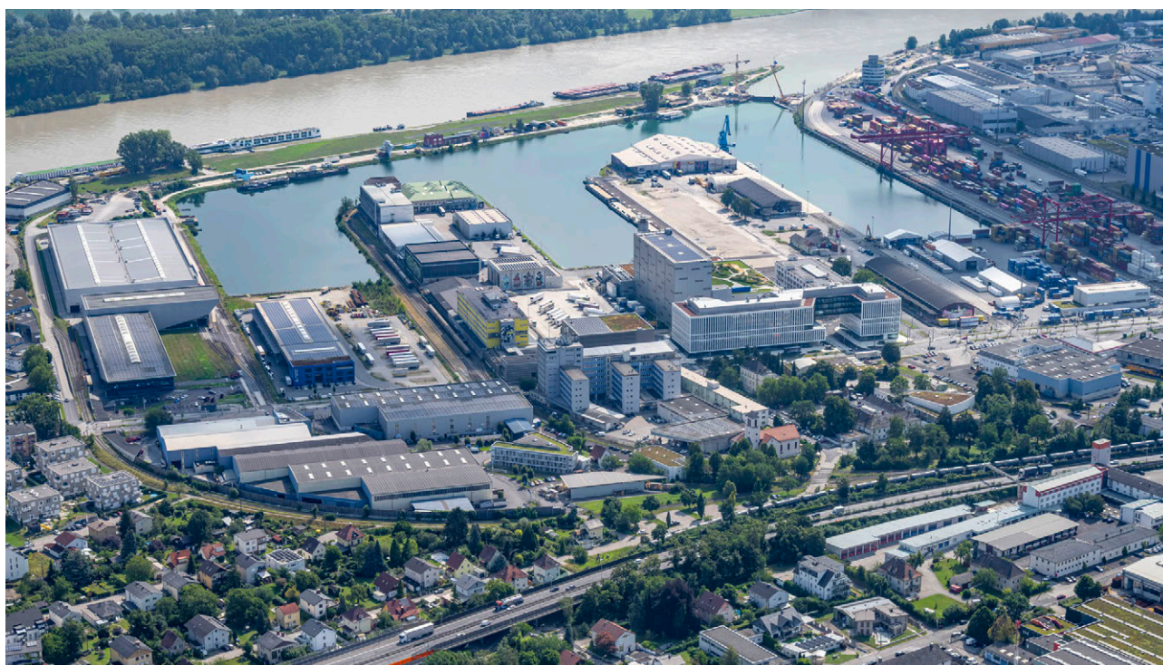
Im Handelshafen Linz errichtet die LINZ AG einen umfassenden Hochwasserschutz.
