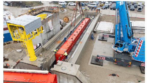
Der erste Teil des Tors ist 27 Meter lang, 1,80 Meter breit und 4,70 Meter hoch.
