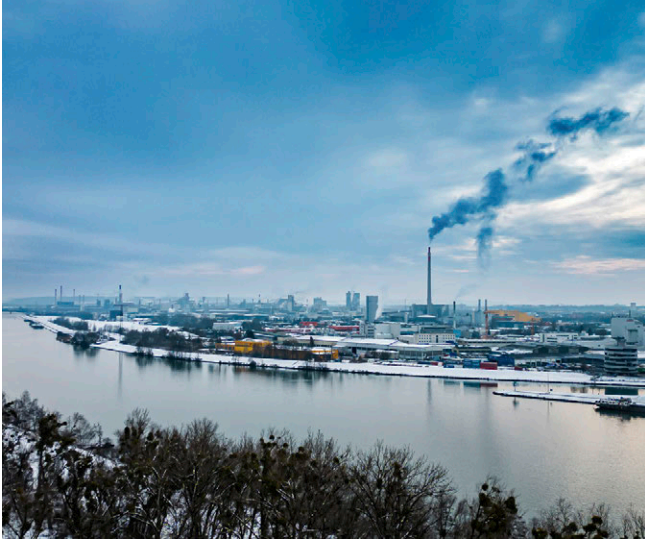
Blick auf das Herzstück der LINZ AG-Energieversorgung: Energiepark Linz-Mitte mit Fernwärmespeicher und Holzlager.
