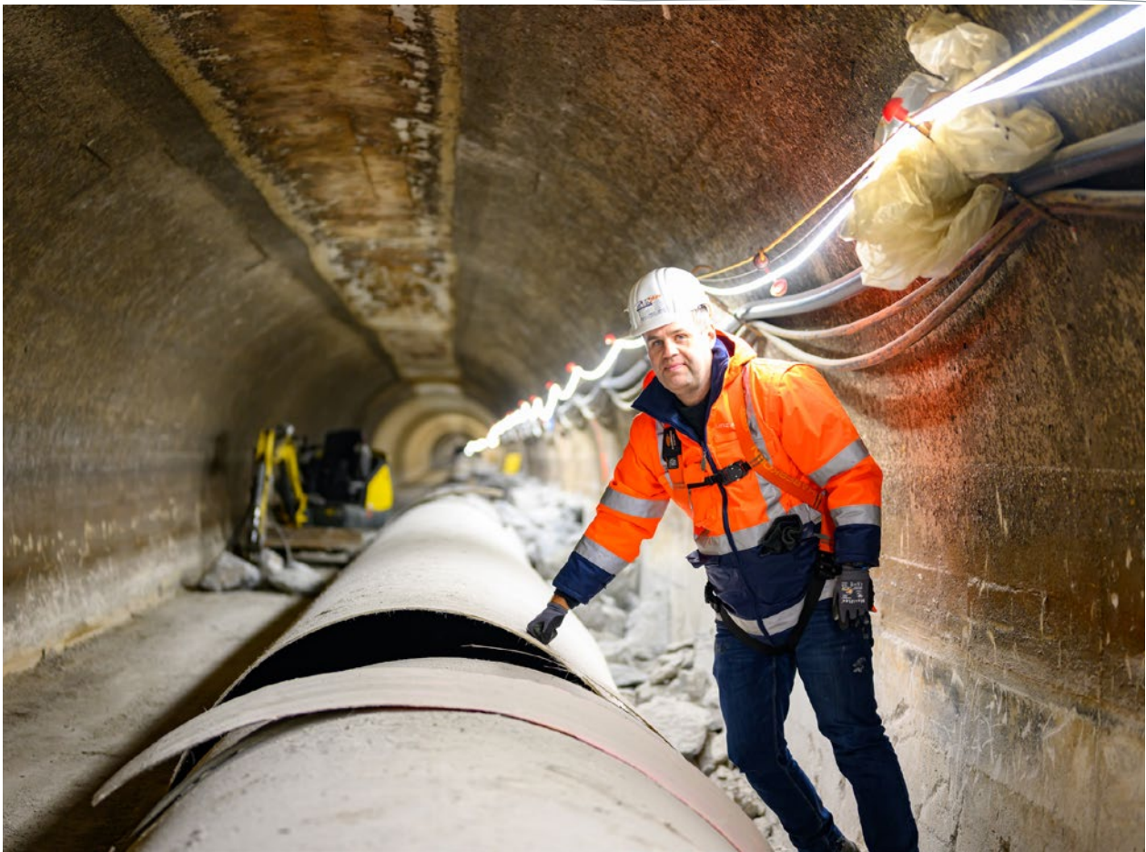
Die Kolleg*innen von LINZ AG ABWASSER arbeiten an der Sanierung des Umleitungskanaldükers. Am Bild: Projektleiter DI Martin Schober. Fotorechte: LINZ AG/P. Kerschbaummayr
